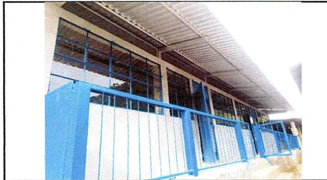
Foto 3. Barrandas, puertas y ventanas ya esta instalado y pintado.
